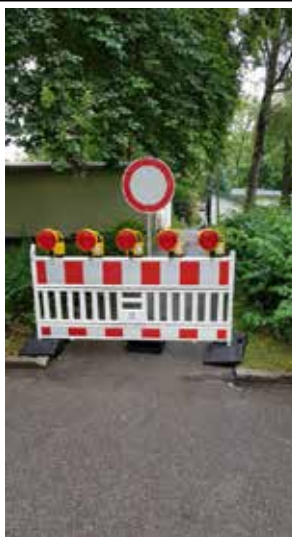
Absperrung des Weges zwischen den Häusern 3 und 4
