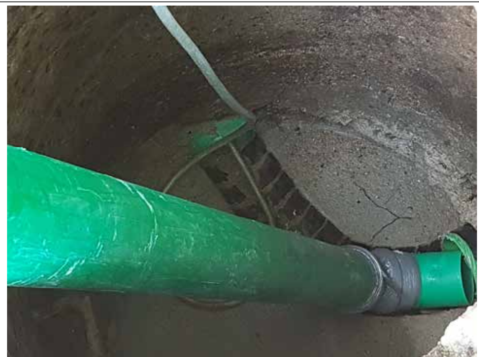
Ein Blick in den Kanalschacht
